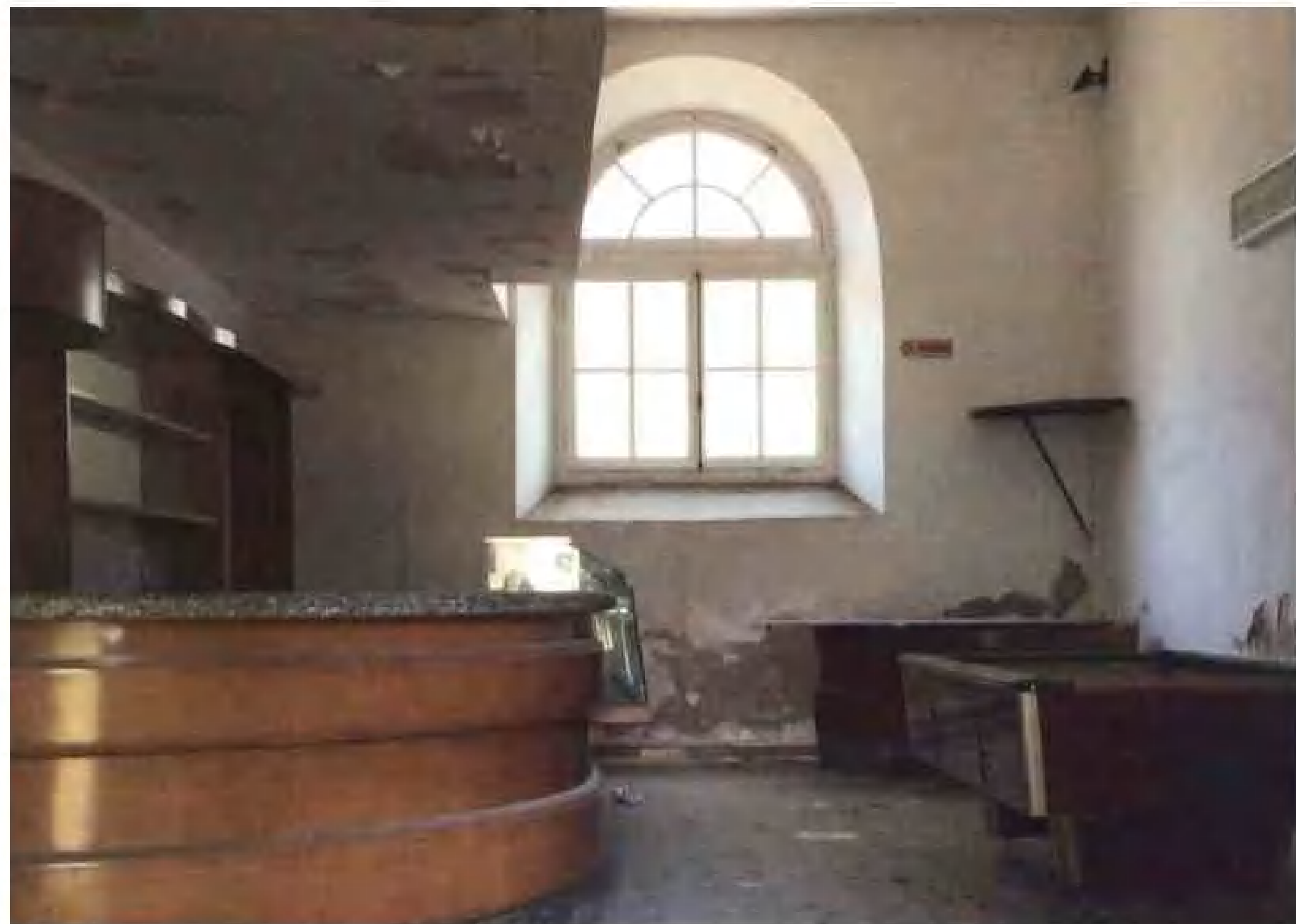
↑ Foto 13_Locale piano terra
