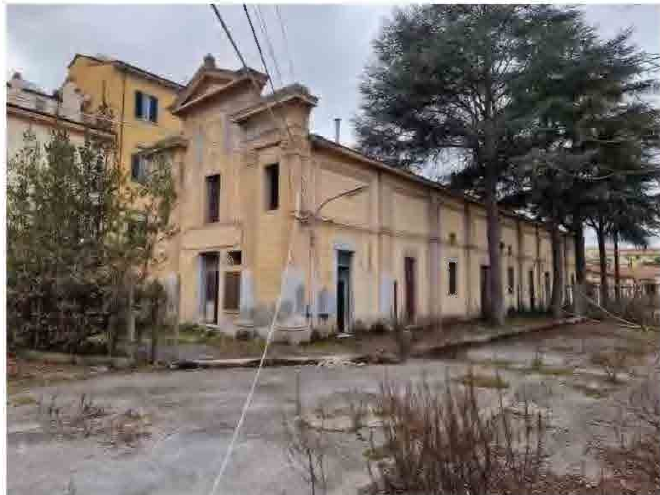
↑ Foto 17_Vista esterna lato A
