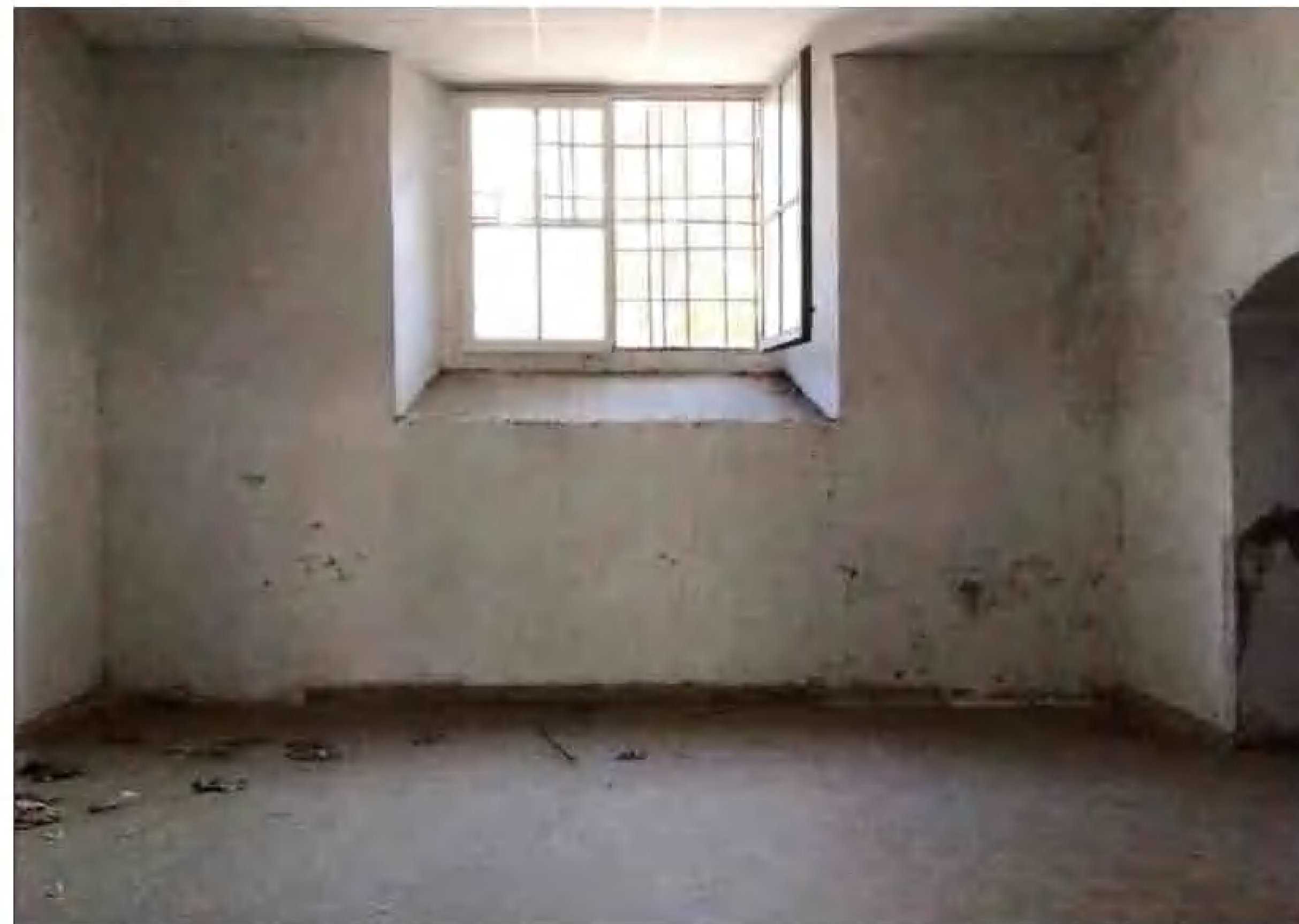
↑ Foto 14_Locale piano terra
