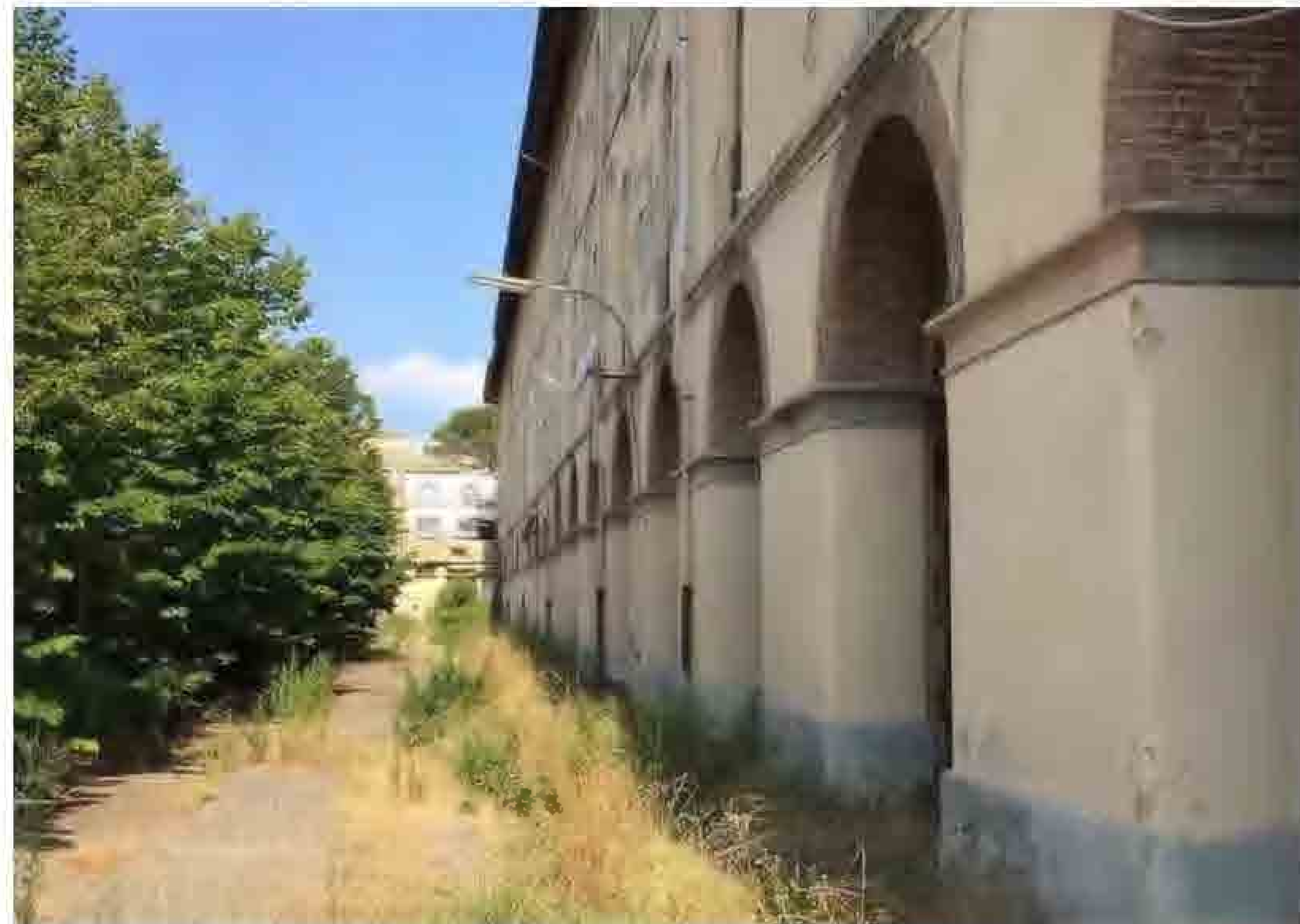
↑ Foto 10_Porticato Edificio Camarate
