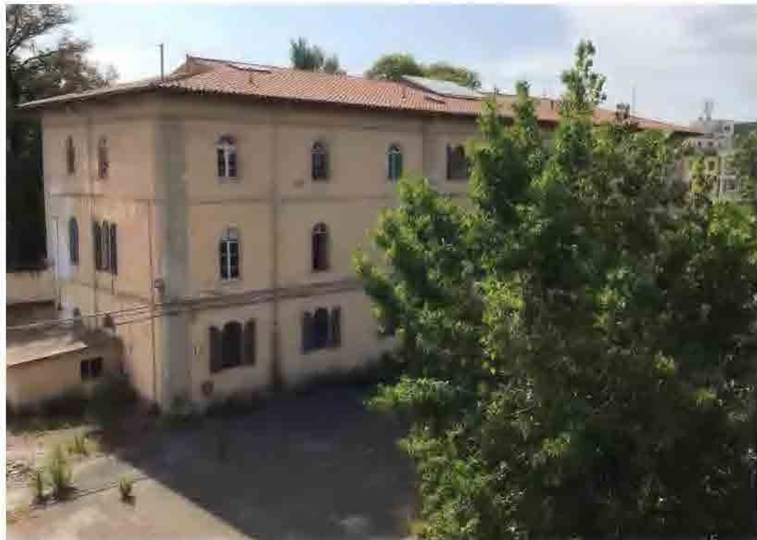
↑ Foto 12_Palazzina Ufficiali
