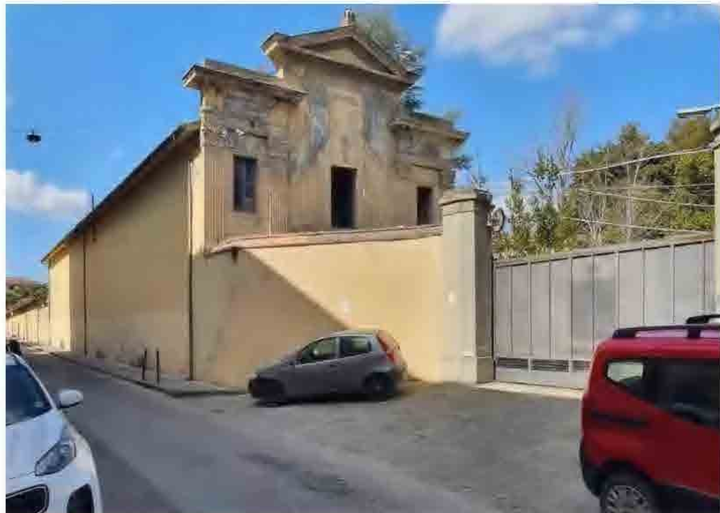
↑ Foto 5_Ingresso Via Derna
