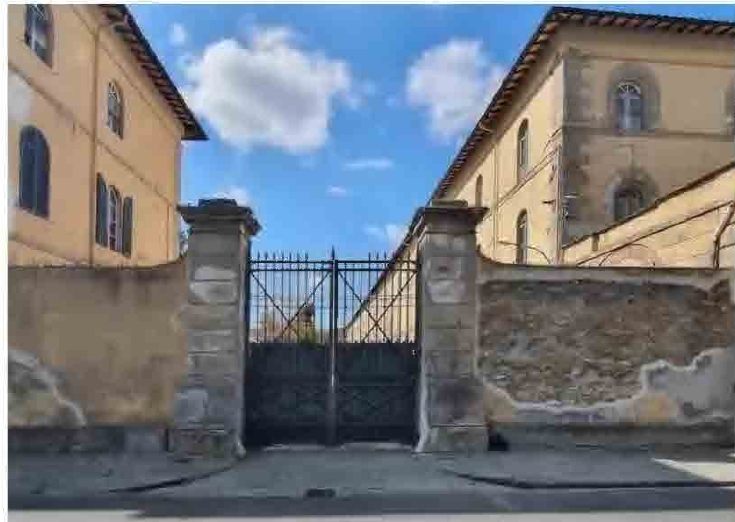
↑ Foto 6_Ingresso su Via Roma
